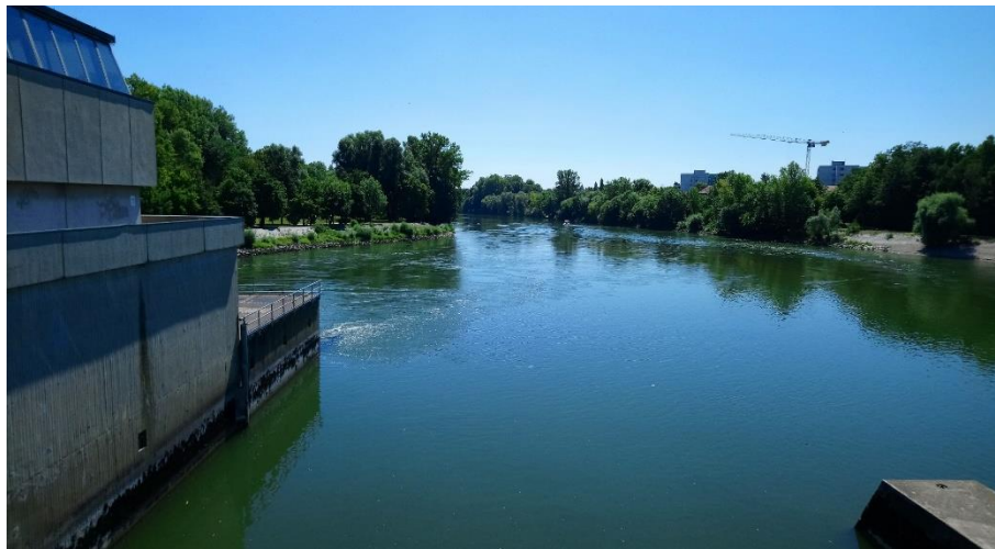
Abbildung 2: Donau, Kraftwerk Regensburg (Quelle: IBF Umwelt)
